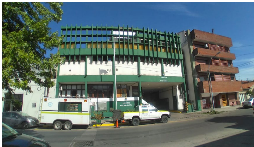
Foto 2: Cuartel de Bomberos, ubicado sobre calle Salta entre Falucho y Gascón
