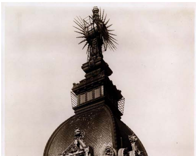
Cúpula en su estado original revestida en pizarra. Gran pieza de herrería. Se destaca el balcón perimetral con su baranda, la profusa ornamentación, sus guardas, modillones, ménsulas, molduras, máscaras, etc.
