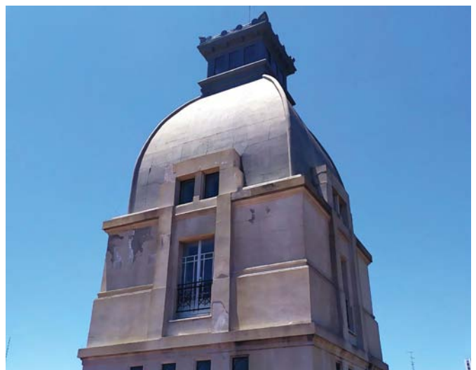
Fotografía actual. Se perdió el remate de la cúpula, el revestimiento de pizarra, el balcón con su herrería y fue "planchado" por completo, despojada de todo elemento ornamental que poseía.
